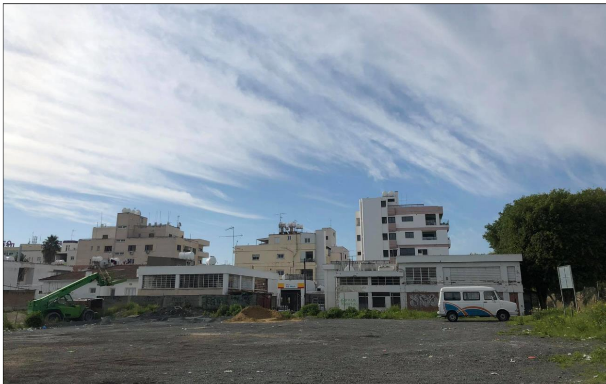
Φωτογραφία 4-3: Νότιο τμήμα της ΑΠΜ
